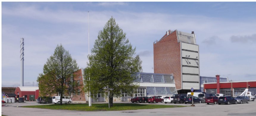
Konekorjaamo torneineen. KUVA: Rakennusinventointi, Arkkitehdit MY 2021
